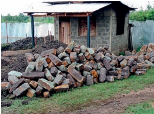
Alte Küche kurz vor dem Abriss
