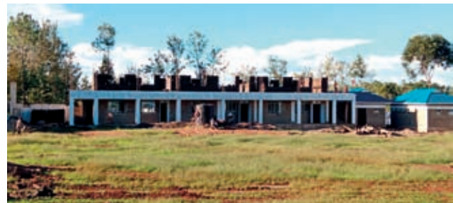
Errichtung des zweistöckigen Schulgebäudes
