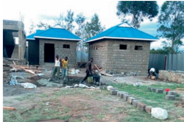
Toilettenhäuschen im Rohbau
