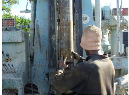
Durch Schlitze im ersten Mantelrohr kann Wasser eindringen.
