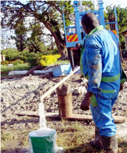
Test der Ergiebigkeit des Bohrlochs und der Qualität des Wassers.
