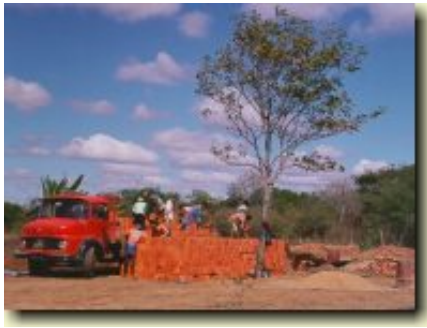
Baustelle der Casa da Farinha in Quebra Guiada
