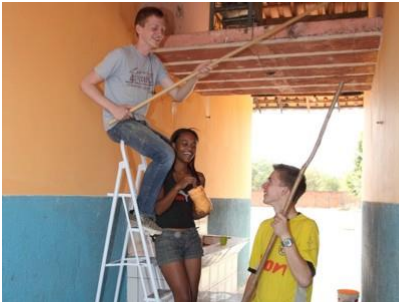
Mit vereinen Arbeitskräften wurden die Fassaden des Schulgebäudes neu angestrichen.
